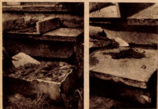
2. A lépcső javítása. 3. Fontos! Az érintkező részek jó tömítése
